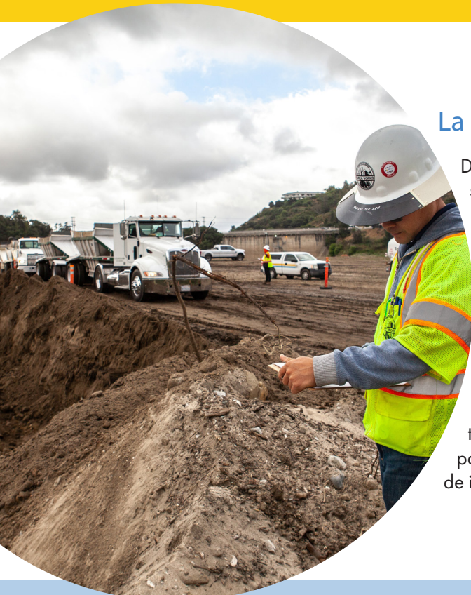
Inspector del Departamento de Obras Públicas trabajando diligentemente en la zona de trabajo
